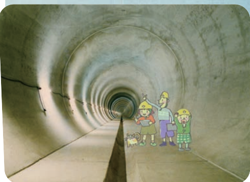
管内の直径 6.5m のなにわ大放水路
