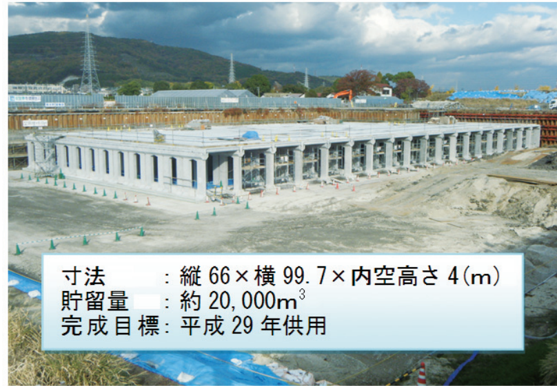
雨水貯留施設 施工状況 (平成 28 年 11 月)
